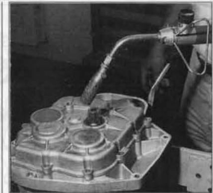
FOTO 75: Calentar a 100°C la tapa de la caja de velocidades para poder desmontarla y volverla a montar (foto RMT)
